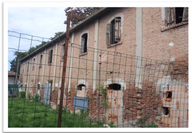
0002-vista prospetto sud
