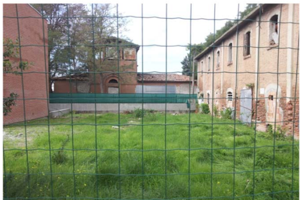
0003-vista prospetto sud con corte
