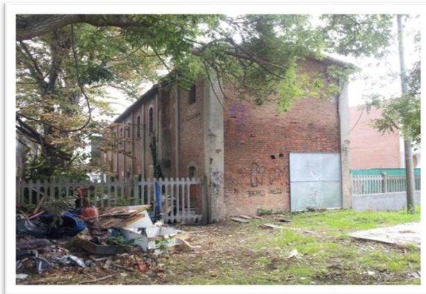
0006-vista prospetto ovest
