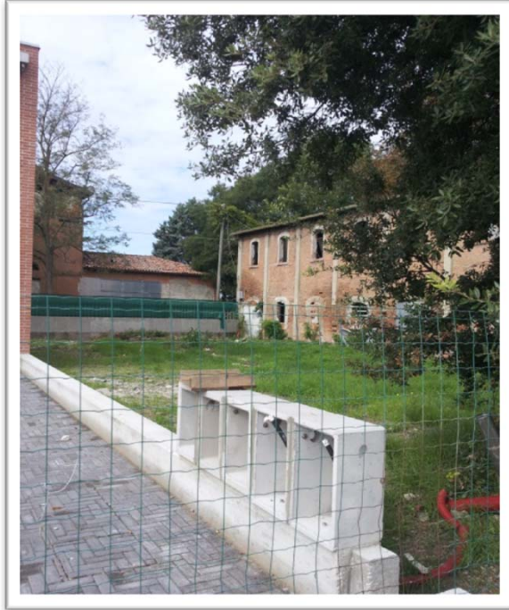
0005-vista prospetto sud
